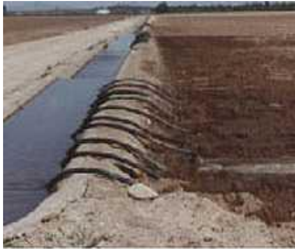
Figure n° 6 Prise d'eau avec siphons
