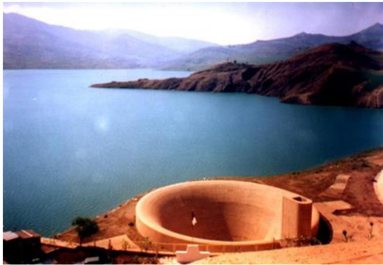
Figure n° 30 : Barrage réservoir de Sidi Yagoub (W. Chlef).
