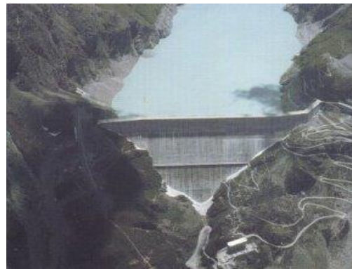
Figure 34b : Vue d'un barrage voûte
