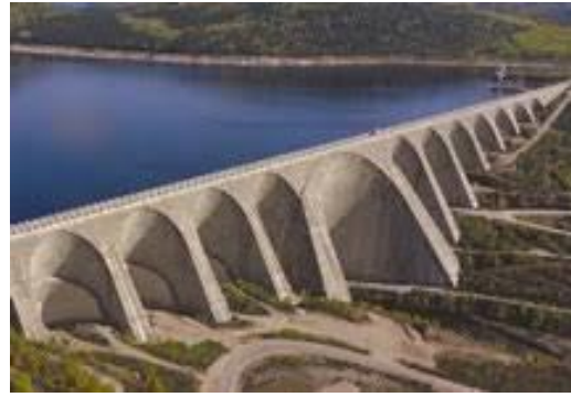
Figure. 35a coupe type d'un barrage à contreforts Figure 35b : Vue d'un barrage à contreforts
