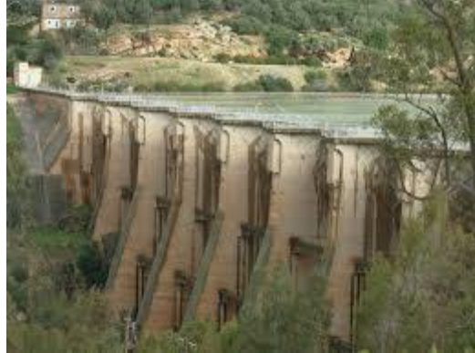
Figure 35c : Barrage à contreforts de Beni Bahdel (W.Tlemcen)
