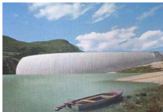
Figure 33b : Vue d'un barrage voûte
