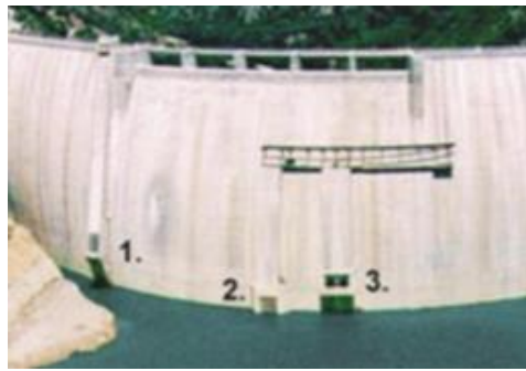
Figure 38 : Parement amont du barrage avec ses annexes
