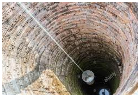
Figure 15 : Puits d'eau creusés ou manuels
