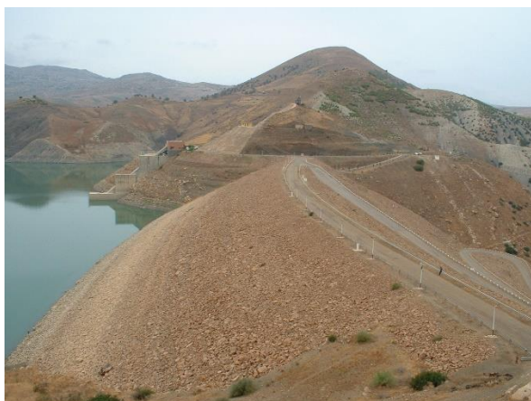
Figure 36b : Barrage de Sidi Yacoub (W. Chlef)
