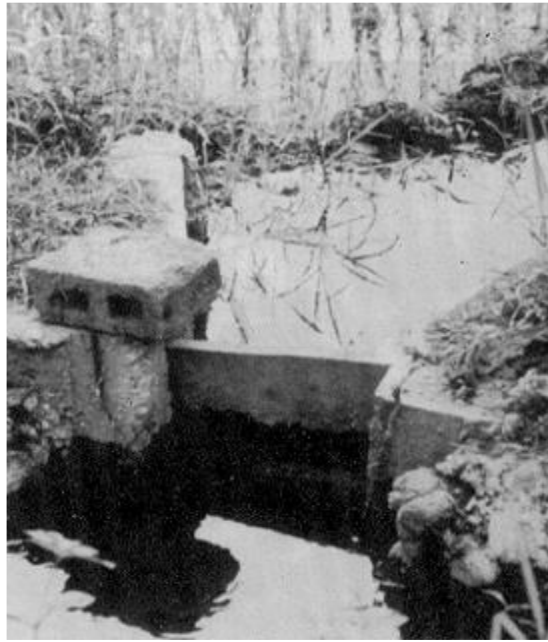
Figure n° 04 : Structure de prise d'eau en maçonnerie
